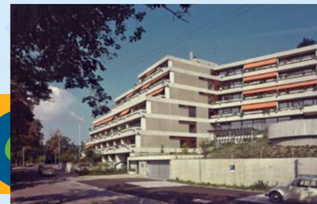
August Hartmann-Haus, das erste Gebäude des Ersatzneubaus Mörikeheim – Baujahr 1969
