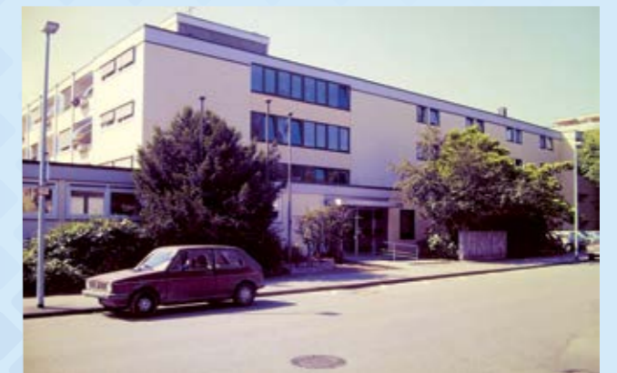
Jakob-Sigle-Heim, Kornwestheim – Baujahr 1966
