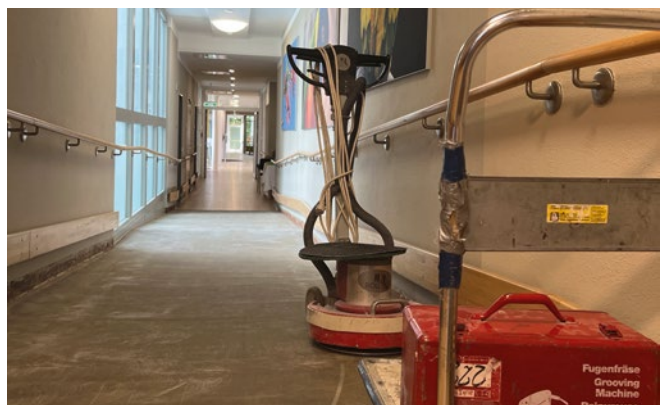
Die letzten Handgriffe am Boden wurden parallel ausgeführt, um den gesamten Bereich schnellstmöglich wieder zugänglich zu machen.
