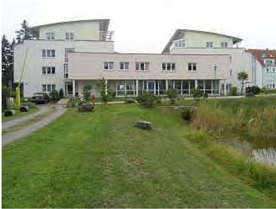
Blick auf die Wohngemeinschaft Casa Vitale im 1. Stock des Gebäudeteils mit Flachdach
